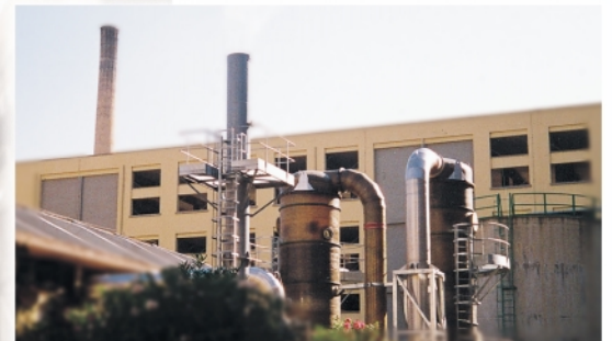
Torre di lavaggio a corpi di riempimento Scrubbing tower with filling bodies
